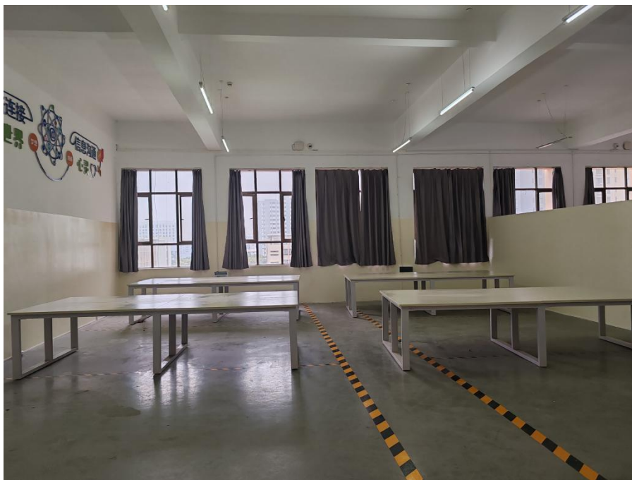
图 7.2 墙面涂刷环保漆
